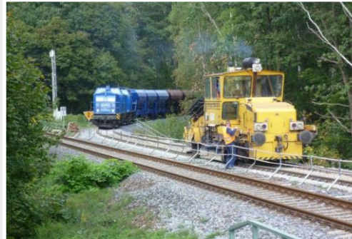
Bauzug am Abzweig
